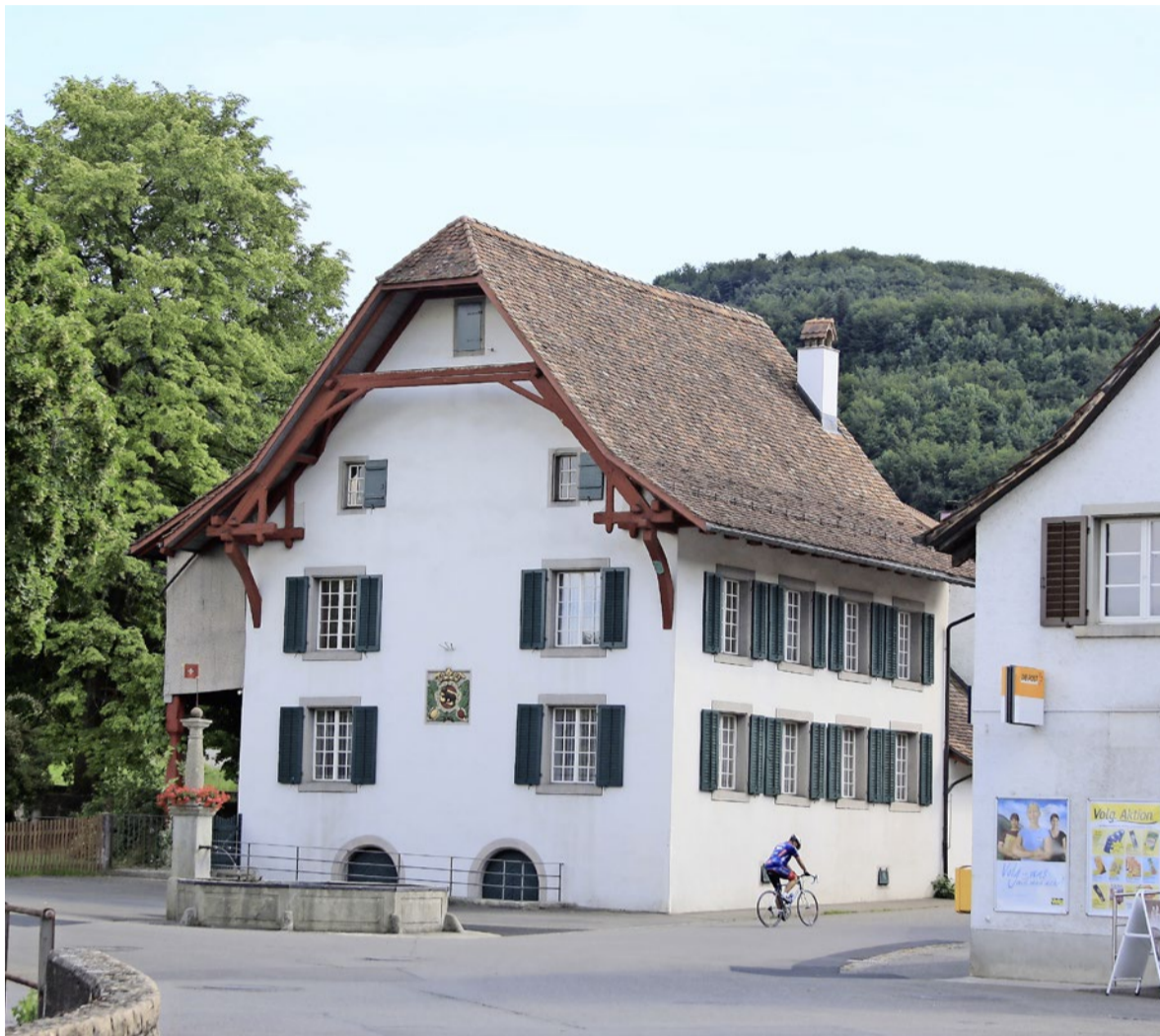
Pfarrhaus Thalheim: Malerisch und denkmalgeschützt, aber bald unbewohnt?
